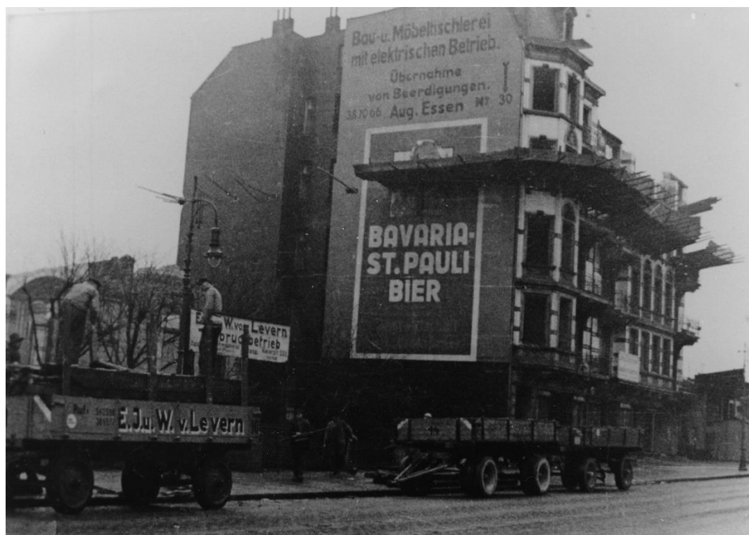
1938 erfolgte der umfangreiche Abriss der Bebauung, in der Tunnelstraße. Die gesamte nördliche Straßenseite wurde abgerissen.
