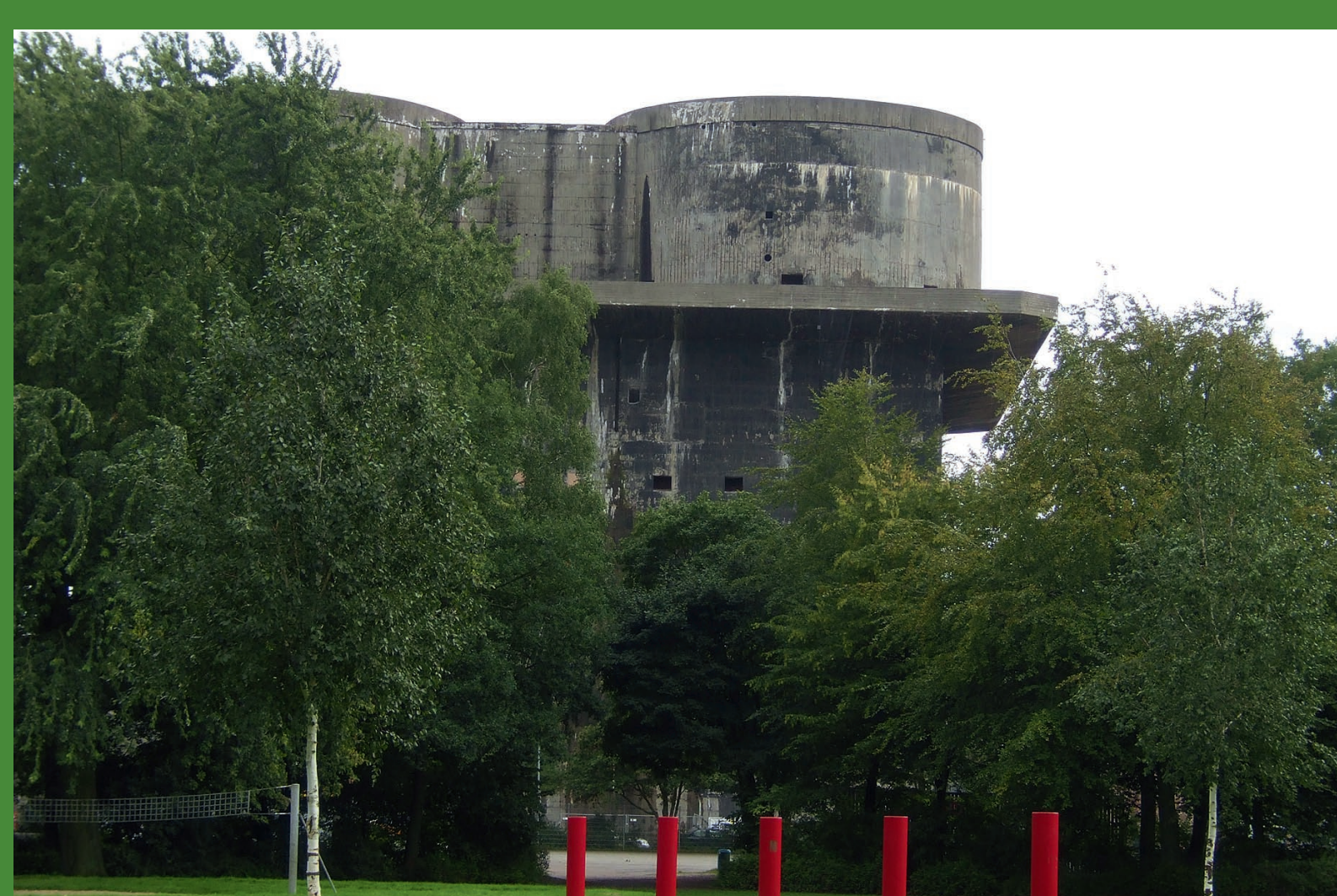
Vom Flakbunker zum „Energiebunker“.
