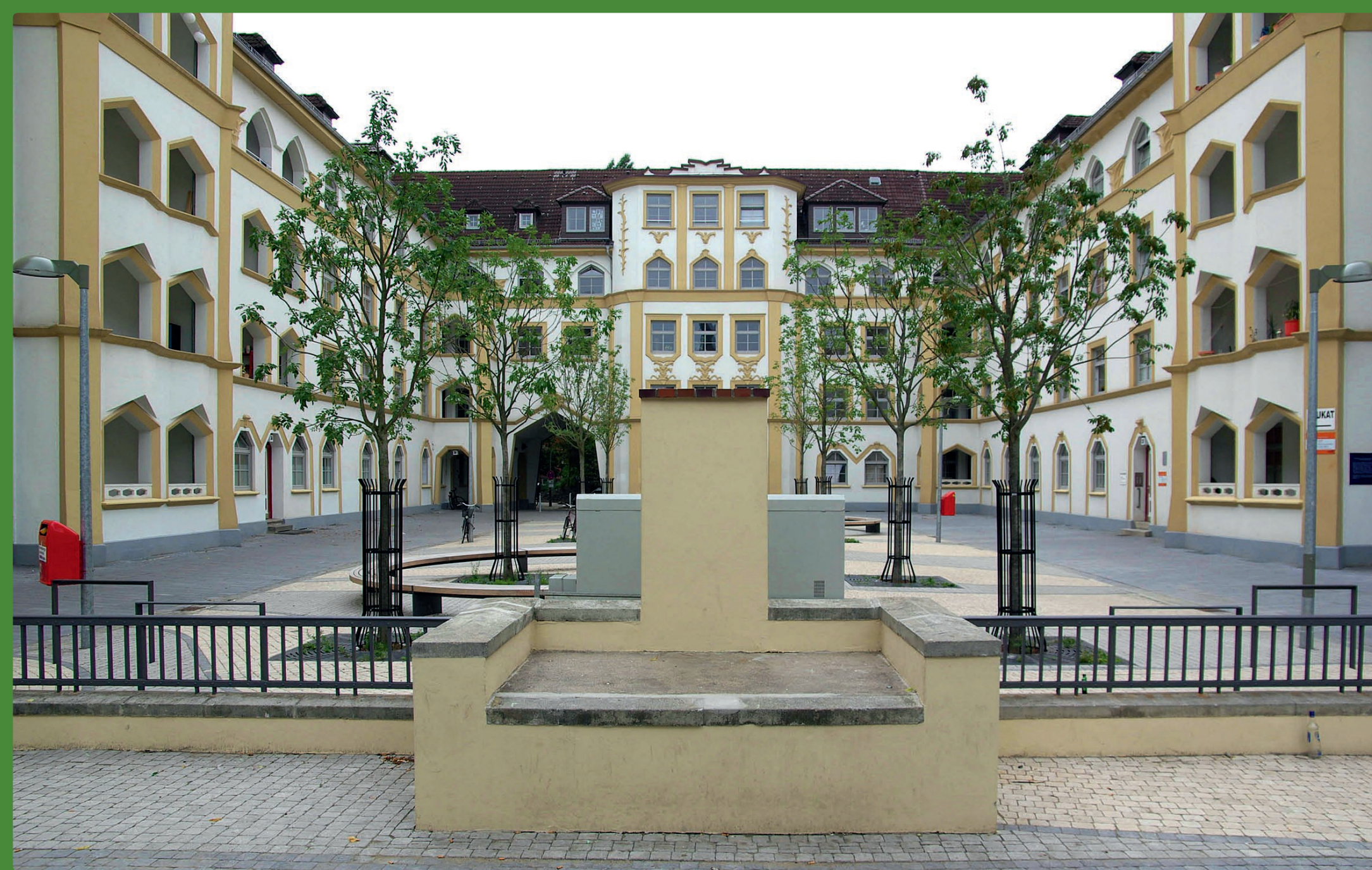
Die expressionistischen Häuser an der Mannesallee wurden saniert.
