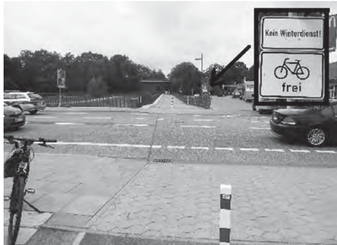
Ein besonders gefährlicher Abschnitt der neuen „Vielzweckstrecke“: die Querung der Dratelnstraße. Dass auf dem gesamten Loop kein Winterdienst sein wird, ist hoffentlich nur ein schlechter Scherz. Fotos/Montage: hk
