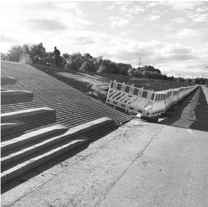
Arbeiten am Berliner Ufer im Oktober 2020. Foto: Henriette Bosse
