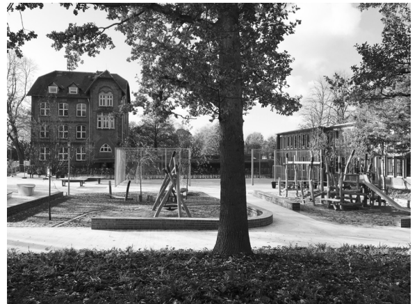
Bereits fertiggestellt: Der modernisierte Quartiers- und Spielplatz vor der Grundschule Rahmwerder Straße. Foto: liz
