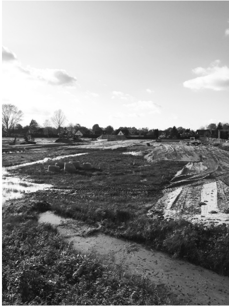
Großbaustelle Kirchenwiesen - hier sind 190 Wohneinheiten geplant. Foto: liz
