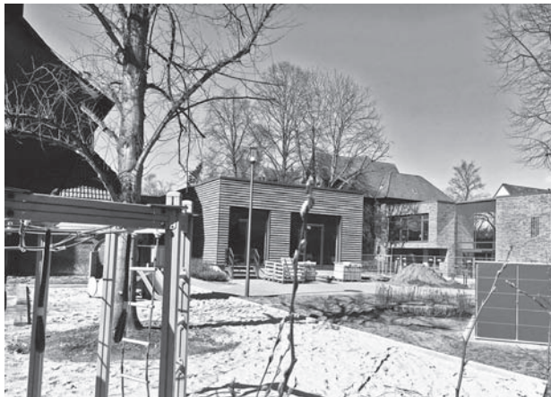
Das neue Gemeindehaus kann von der Kirche aus betreten werden und öffnet sich zum Freigelände. Foto: MG
