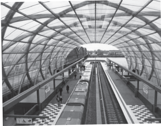
Von der neuen Endstation kann man das südliche Elbufer schon sehen. Foto: hk
