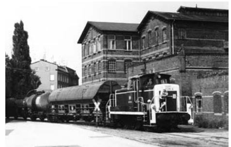
Die ehemalige Margarine- und Honigfabrik wird 40 Jahre alt. Hier ein Bild aus dem August 1981. Foto: Geschichtswerkstatt
