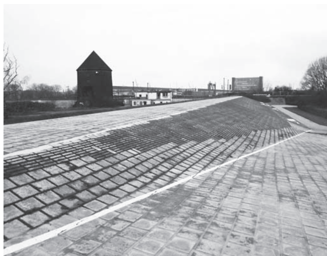
Der erste Abschnitt des neuen Deicherhöhungsprogramms am Veddeler Elbdeich ist abgeschlossen. Foto: MG
