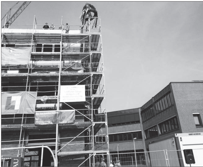
Richtfest für das Unterrichts- und Mensagebäude im Berufsschulzentrum an der Dratelnstraße. Der Richtkranz musste mit einem Kran auf den Neubau gehievt werden.
