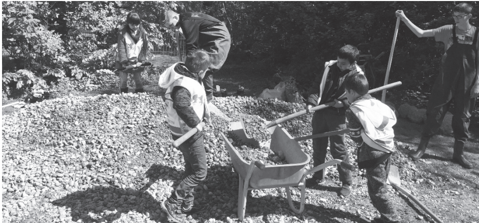
Groß und Klein arbeiten zusammen: Der Kies muss ans Ufer gebracht werden. Das erledigen die Neunt- und Erstklässler gemeinsam. Foto: ein
