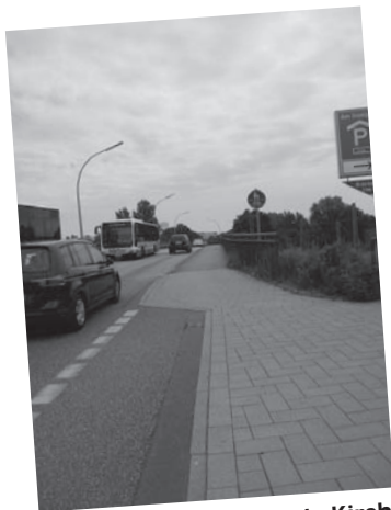
... und aus! Radwegende Kirchdorfer Straße/S-Bahn-Brücke.
