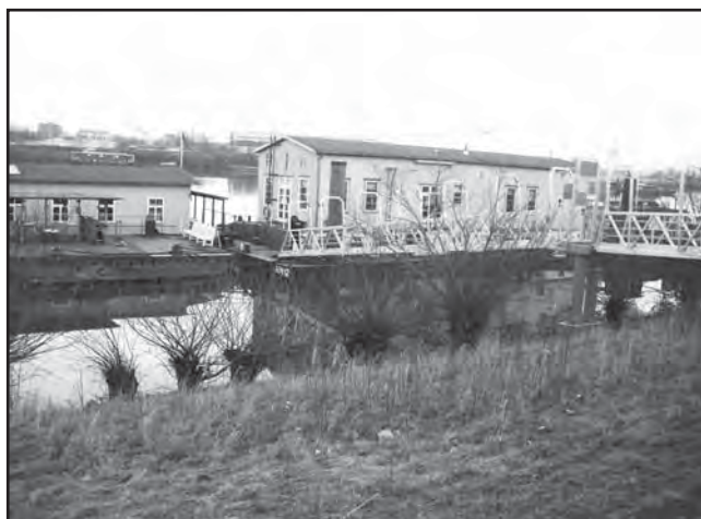
Die neue Brücke 14 am Berliner Ufer im Spreehafen führt auf die Pontons mit der historischen Liegeranlage des Hausbootvereins.
