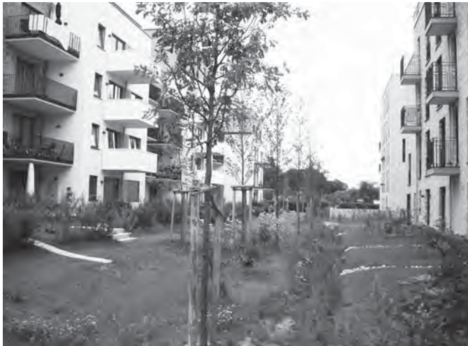
Gutes Beispiel für einen naturnahen Regenwasser-Rückhaltegraben in Lokstedt.
