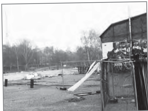
Sicherheitszaun mit mangelnder Standsicherheit. Foto: hk
