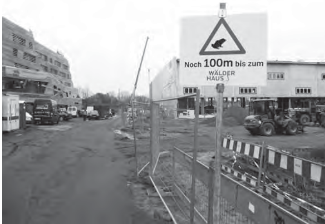
Hier geht's zum Wälderhaus ohne Wald. Die Baustelle auf dem igs-Gelände, links hinten das neue Gebäude. Foto: hk
