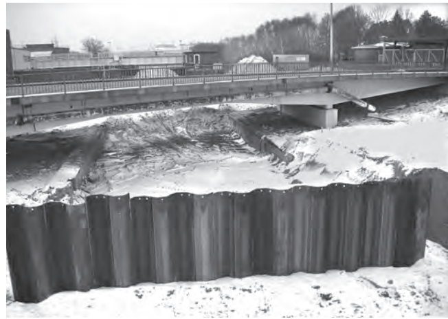
Die provisorische Spundwand an der Ernst-August-Schleuse. Foto: MG
