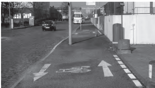
Nimmt langsam Gestalt an: Der Multifunktionsweg auf der Strecke zum Alten Elbtunnel. Viele sind begeistert, doch auch Kritik wird laut: Ist der Weg zu eng, zu gefährlich, fahrradfeindlich? Foto: J.v.Prondzinski
