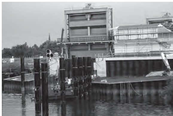
Die Ernst-August-Schleuse wird gerade neu gebaut.
