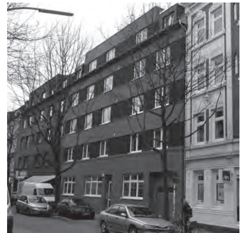
Sanierung im Vogelhütten-deich 72.
