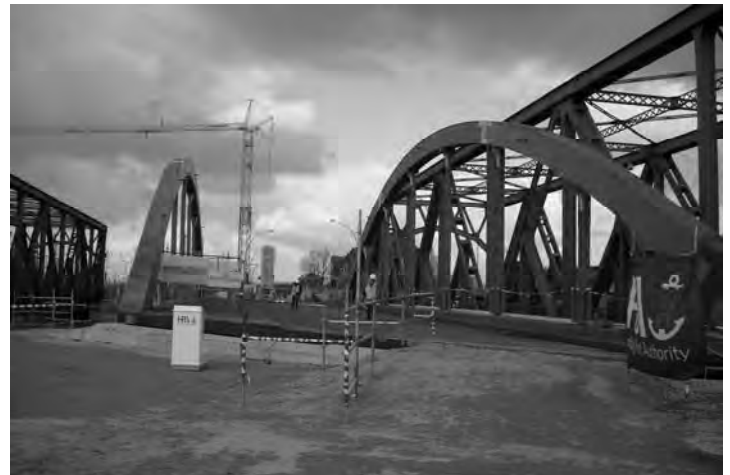
Die neue Brücke am Veddeler Wasserkreuz liegt auf.
