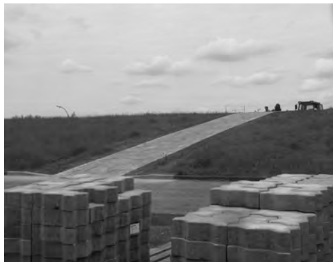
Jetzt ist der Übergang über den Deich an der Hafenanrandstraße fast fertig.
