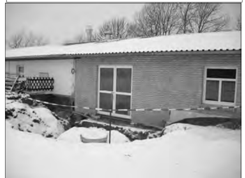
Das Jugendhaus Moorwerder ist noch im Bau.
