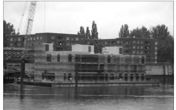
Das IBA-Dock im Bau
