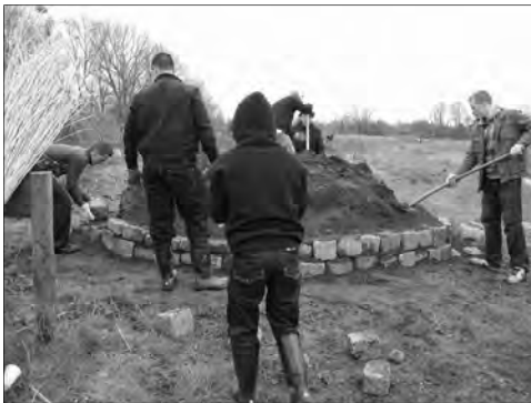
Bau einer Kräuterspirale
