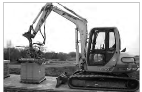
Obergeorgswerder. Ein Logistikzentrum entsteht auf grüner Wiese. Foto: Archiv
