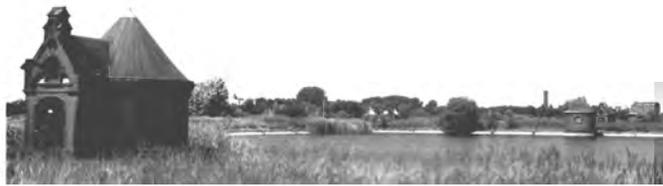
Die zylindrischen roten Brunnen- oder Schieberhäuser auf der Kaltehofe dienen dem Rohwasserzufluss und Reinwasserabfluss.
